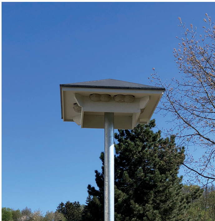
Grundmaße ca. 1,60 x 1,60 x 0,65 m, verzinkte Rohrsäule als Kippmast mit U – Profilen, Gesamthöhe ca. 5,50 m
