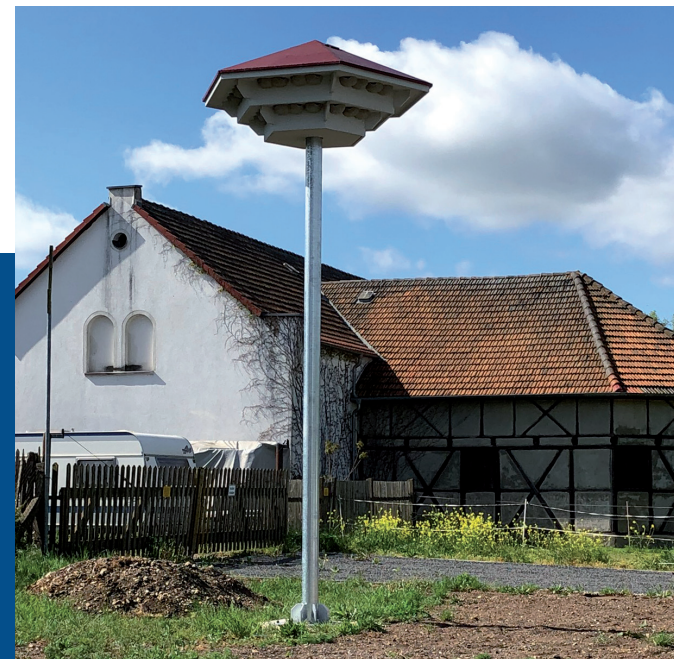
Grundmaße ca. 2,45 x 2,45 x 1,25 m, verzinkter Mast mit Fuß, Gesamthöhe ca. 6,50 m
