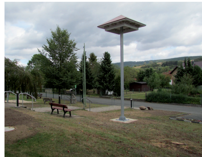
Grundmaße ca. 2,05 x 2,05 x 0,65 m, verzinkter Mast mit Fuß, Gesamthöhe ca. 6,50 m
